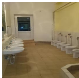
7/2016 rekonstrukce WC v MŠ
